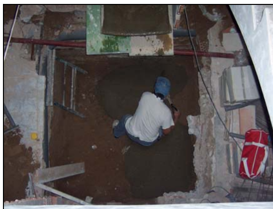
Detall de les feines de formigonat de la fossa, un cop finalitzat el rebaix.
