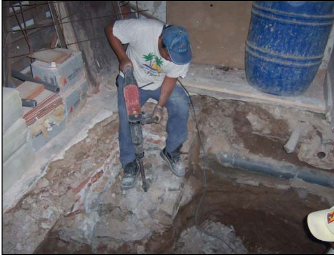
Vista dels treballs de desmuntatge del mur UE 105.
