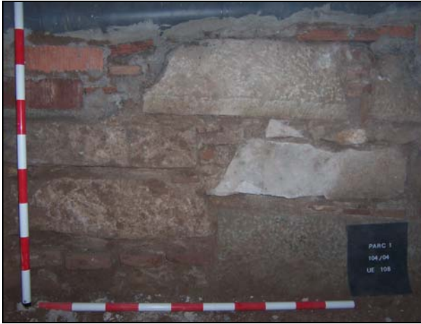
Detall del parament del mur UE 105.
