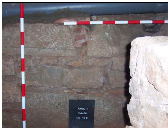
Detall del parament del mur UE 108.
